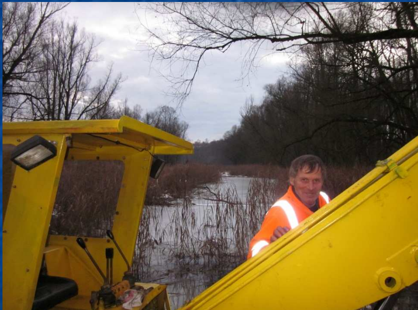
Baggerführer Sepp bei der Arbeit
