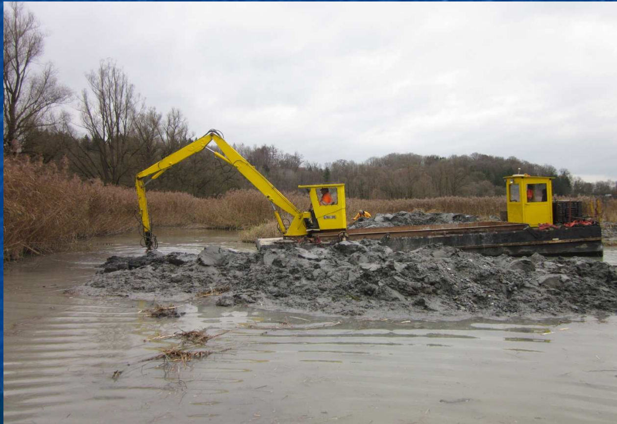
Eintiefung zur Positionierung des Bagger am geplanten Verbindungsgraben
